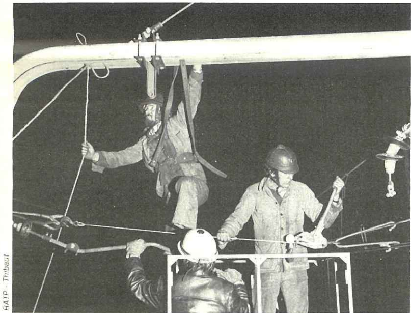
Armement d'un poteau : montage d'une console à bec.
