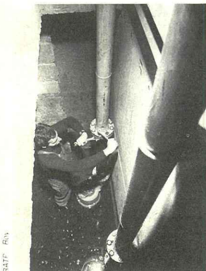
Vérification des pompes immergées et des tuyaux de refoulement.
