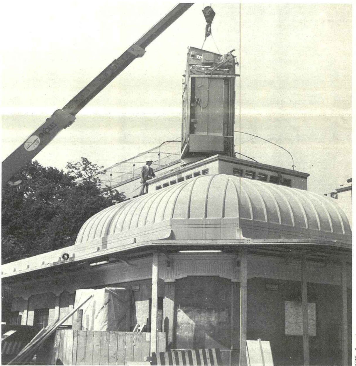
Introduction d'une cage d'ascenseur à la station « Porte des Lilas ».
