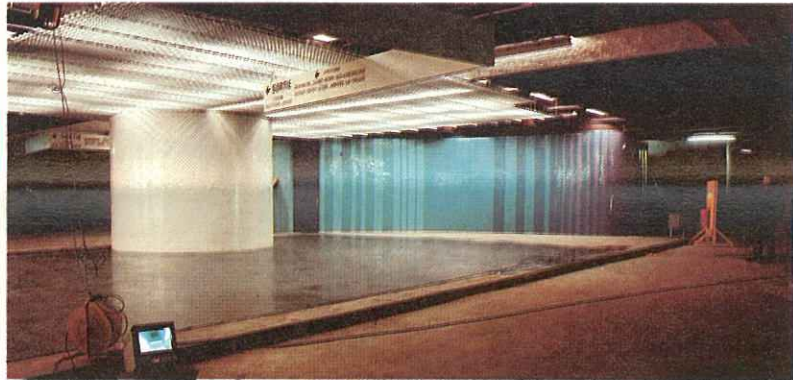
Prototype du platonnement lumineux de la station « Châtelet-Les Halles » et habillage circulaire des escaliers d'accès aux quais, au niveau de la salle des échanges RER.
