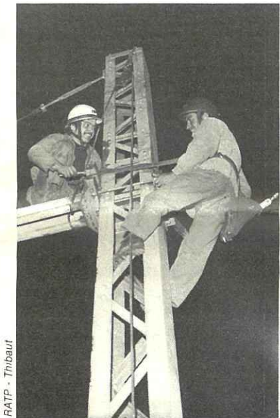
Blocage du talon de console.
