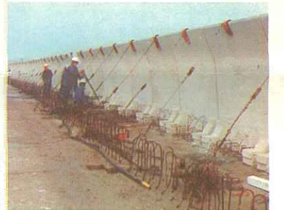
Mise en place des garde-corps sur le pont de Neuilly-Plaisance.
