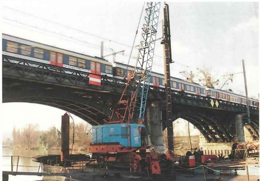
Essai de battage à proximité d'une pile.
