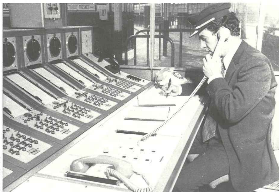
Commandes centralisées des départs : équipement ancien.
