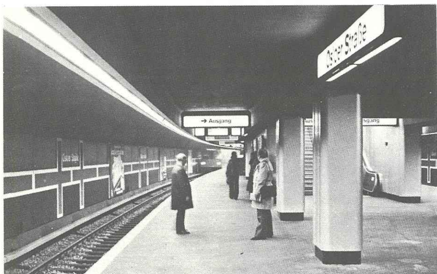
Station « Osloer Strasse » (mise en service en 1976).
