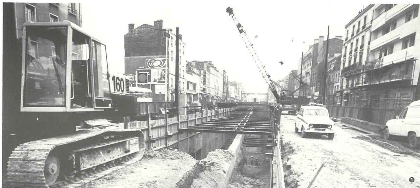
RATP - Travaux neufs
