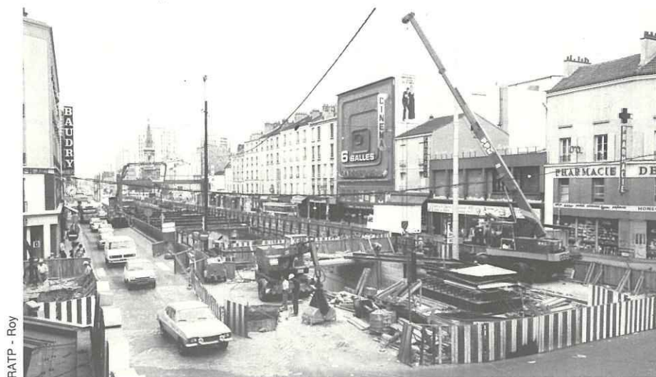
Chantier à Aubervilliers, avenue Jean Jaurès.
