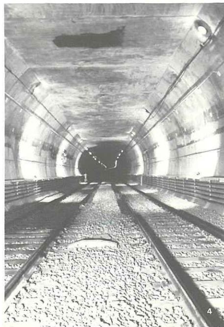
RATP - Travaux neufs
