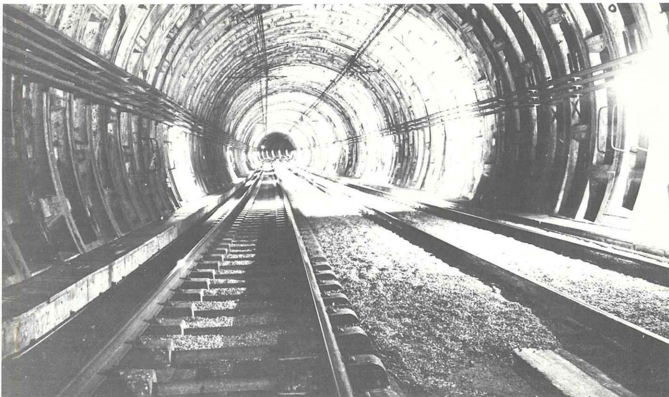
Une première livraison a été faite pour équiper une quarantaine de mètres du tunnel à voie unique de La Défense. Le gain obtenu est actuellement faible (1 à 2 dB) car les semelles sont trop raides. Dans ce même tunnel, une expérimentation entre deux tronçons de pose RS-STEDEF à semelles sous blochets de 12 mm et de 24 mm semble révéler une atténuation supplémentaire, mais le gain en filtrage risque d'aller à l'encontre de la stabilité de la voie.
