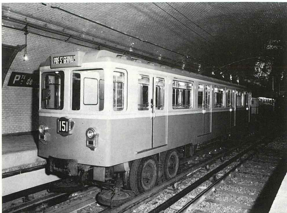
La navette de la Porte-des-Lilas, prototype du métro sur pneus et du pilotage automatique.
