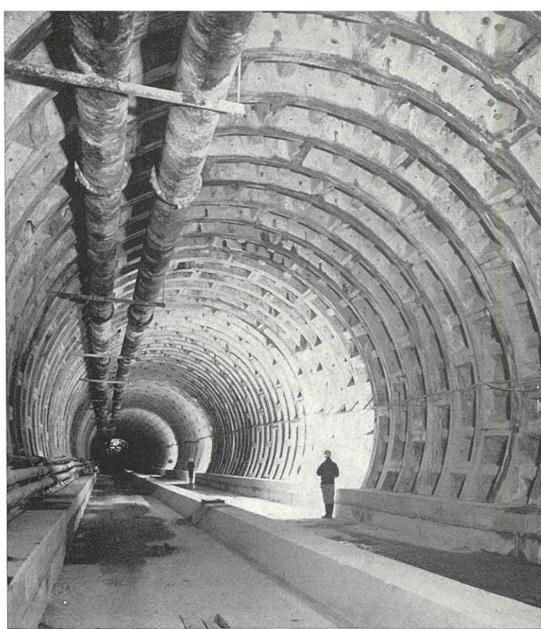
Vue générale du tunnel après achèvement de la plate-forme sous voie entre « La Défense » et le « Pont de Neuilly ».
