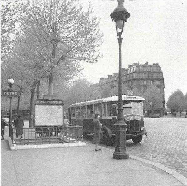
Débouché classique, entourage en fer forgé monté sur socle en pierre de taille de Comblanchien, avec plan et candélabre
