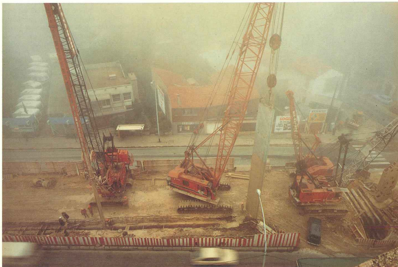
7. Matériels utilisés pour la mise en place des parois préfabriquées sur le lot 4.
