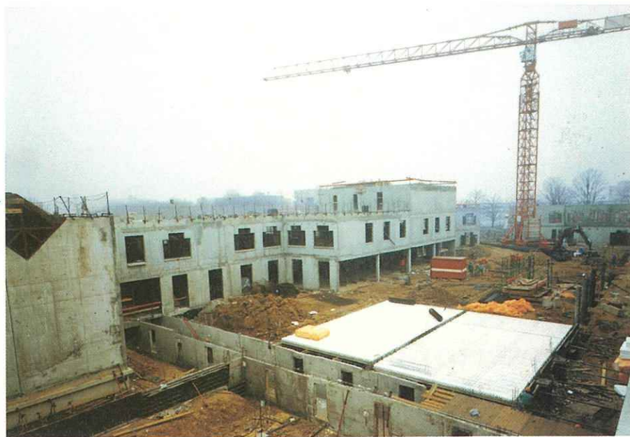
La galerie technique et, derrière, le vide sanitaire du restaurant.
