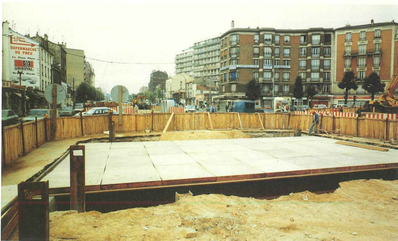
14. Pose de platelages en béton armé.
