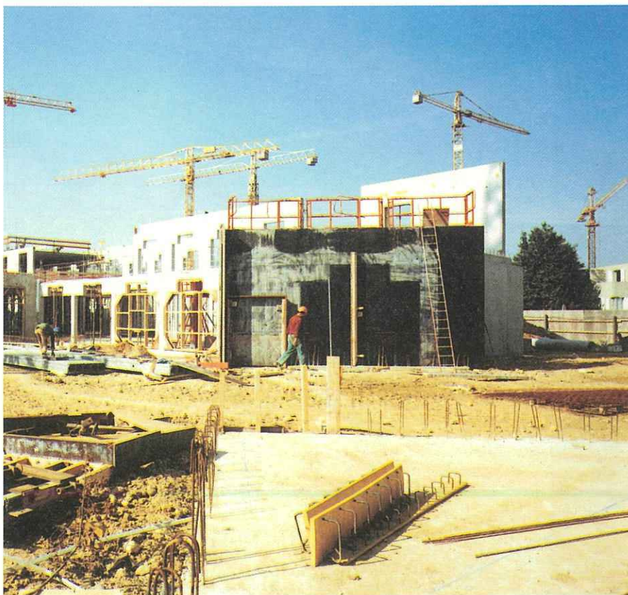
Au premier plan en bas, présentation d'une bande d'attente avant mise en place dans le coffrage.
