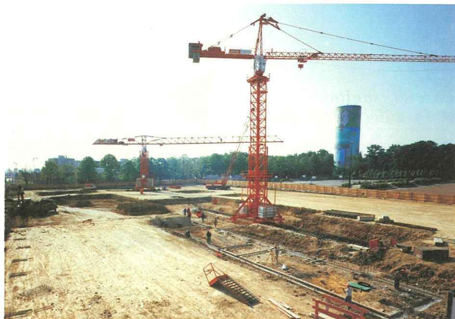
Plate-forme stabilisée et vides sanitaires terrassés - Fondations du gymnase en cours (juin 1983).
