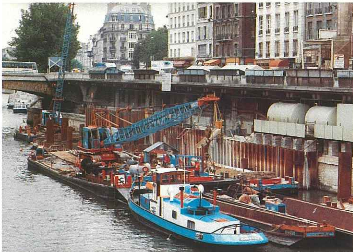
Travaux de construction de la gare Saint-Michel sur la ligne B du RER.
