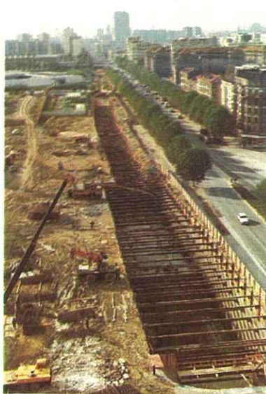
Station « Fort-d'Aubervilliers » : exécution du radier
