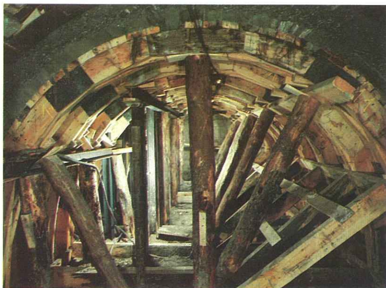
Chambre de départ du souterrain : blindages et coffrages spéciaux
