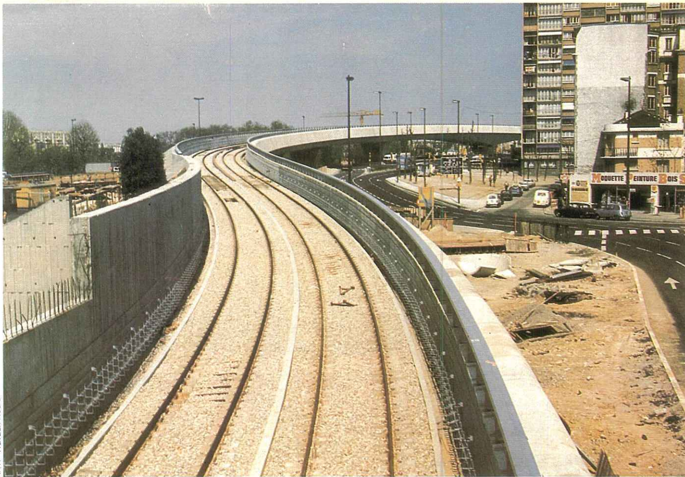
Ligne 13 bis : le viaduc d'accès au port
