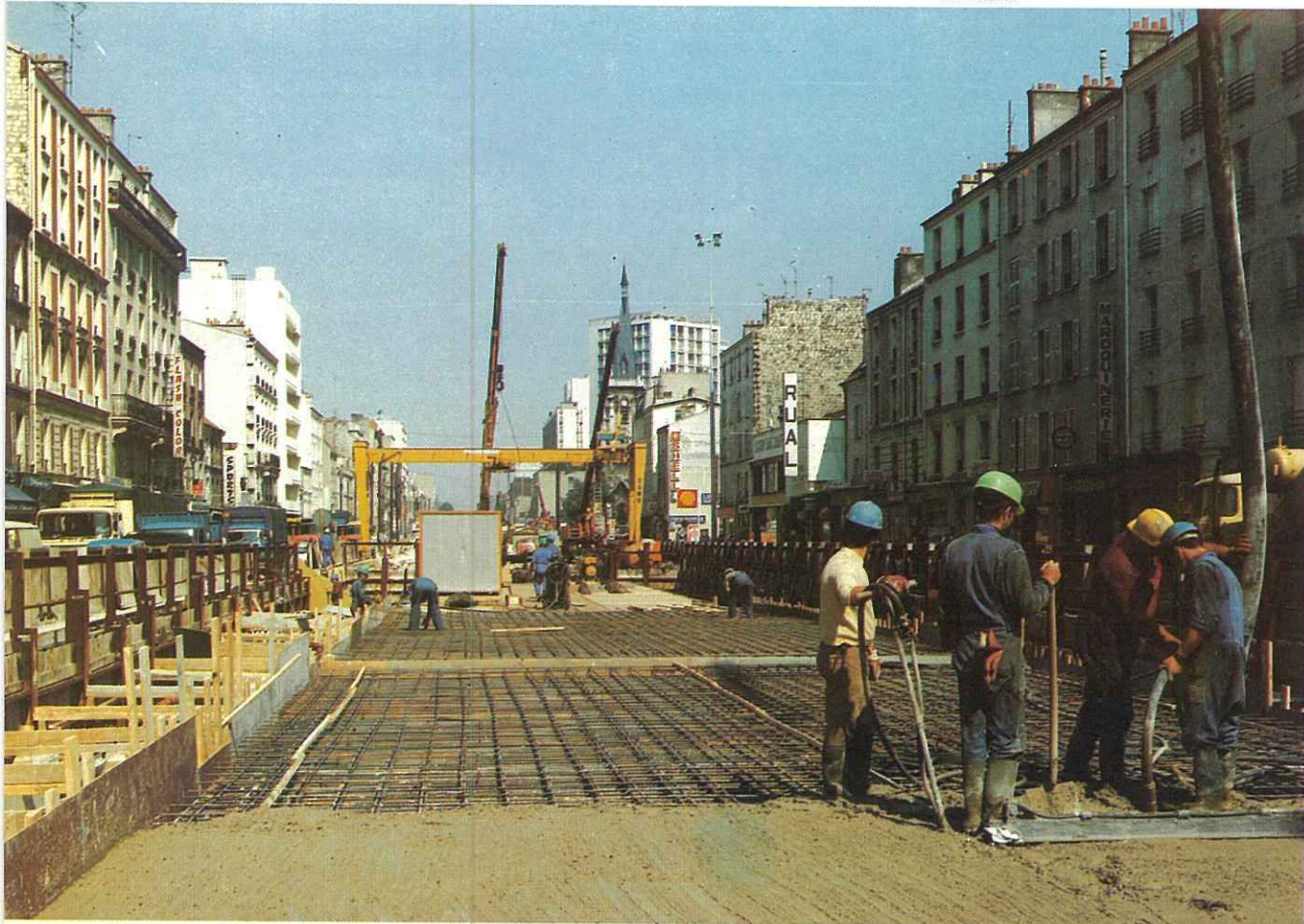
Bétonnage de la couverture provisoire du passage routier
