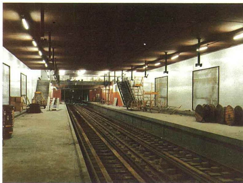
Station « Aubervilliers - Pantin - Quatre Chemins »
