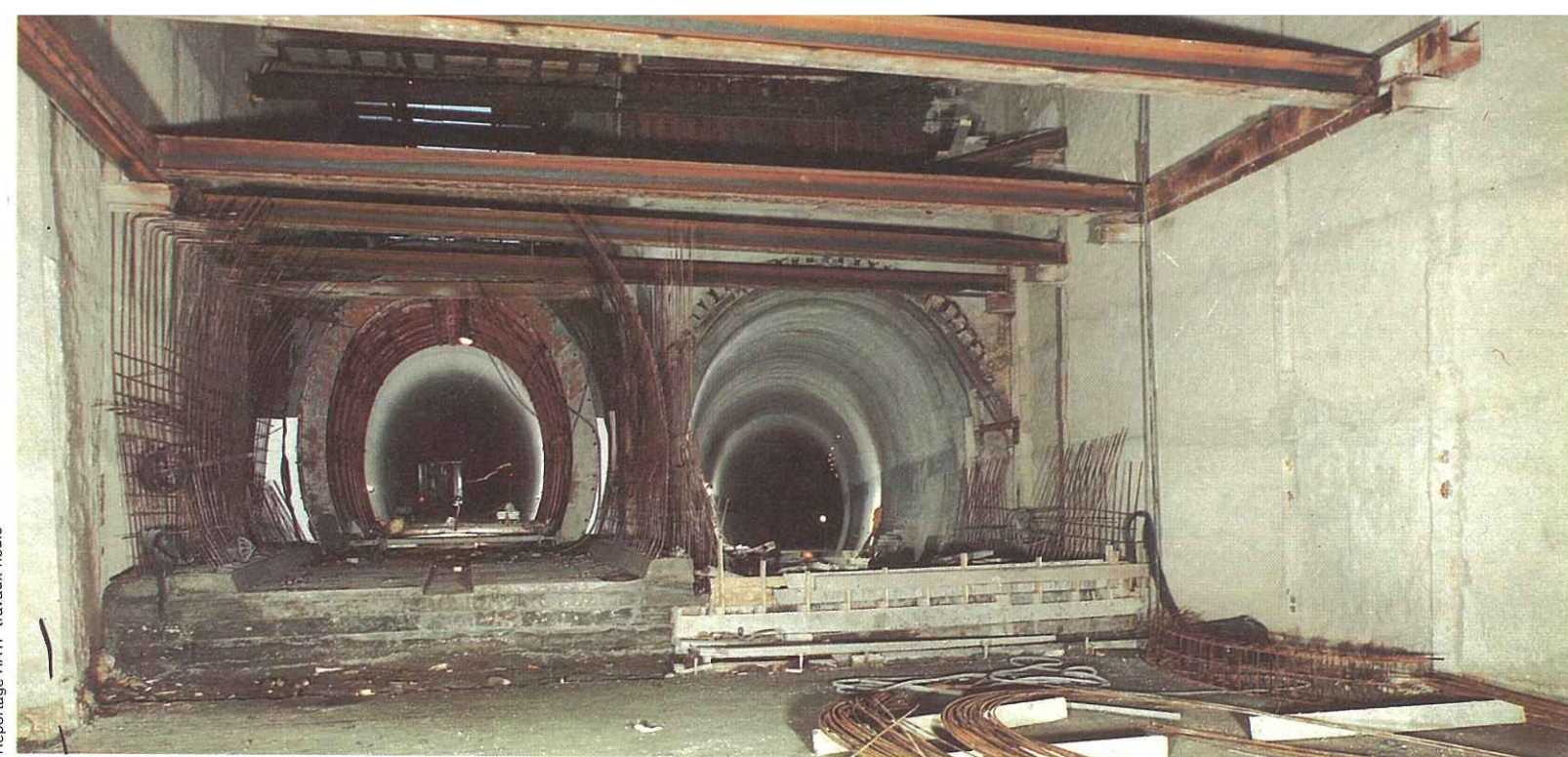
Arrivée des deux tunnels à voie unique dans l'ouvrage de convergence
