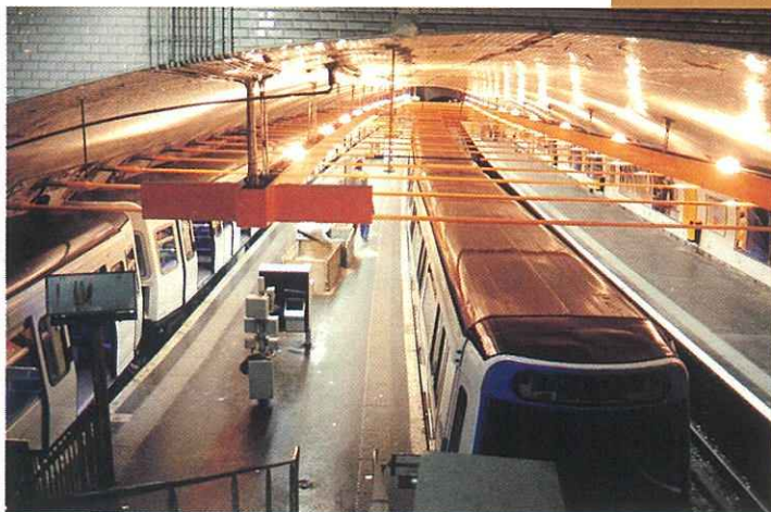
La station compte 41 tirants : chaque tête de tirant supporte une traction de 60 tonnes.
