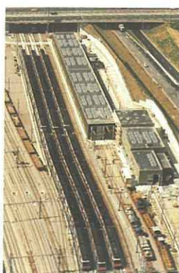
L'arrière-gare de Torcy remaniée
