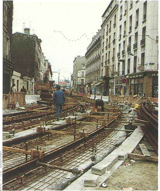
Poursuite des travaux du tramway dans Saint-Denis (janvier 1992)
