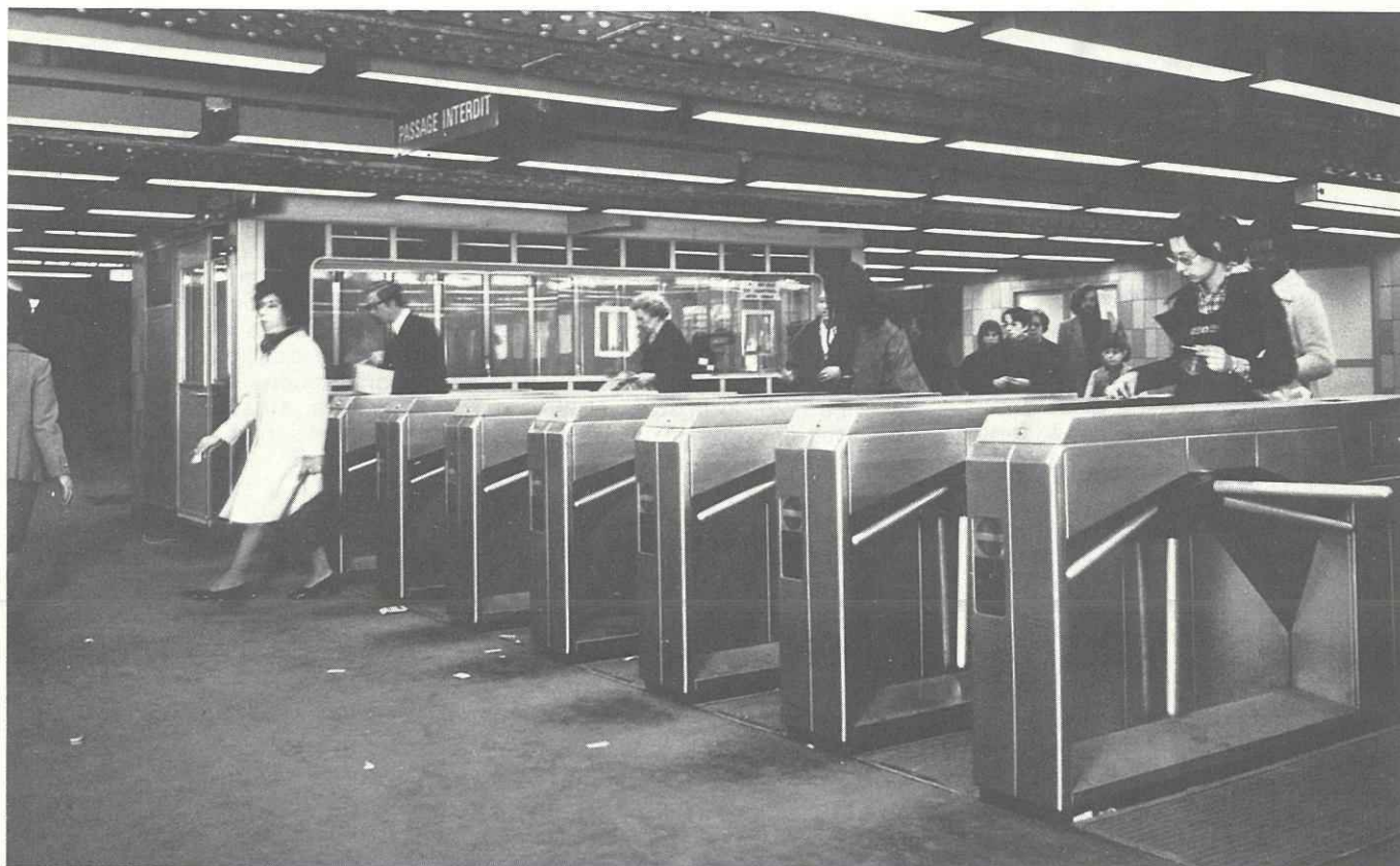
Batterie de tourniquets à quatre bras à la station République.
