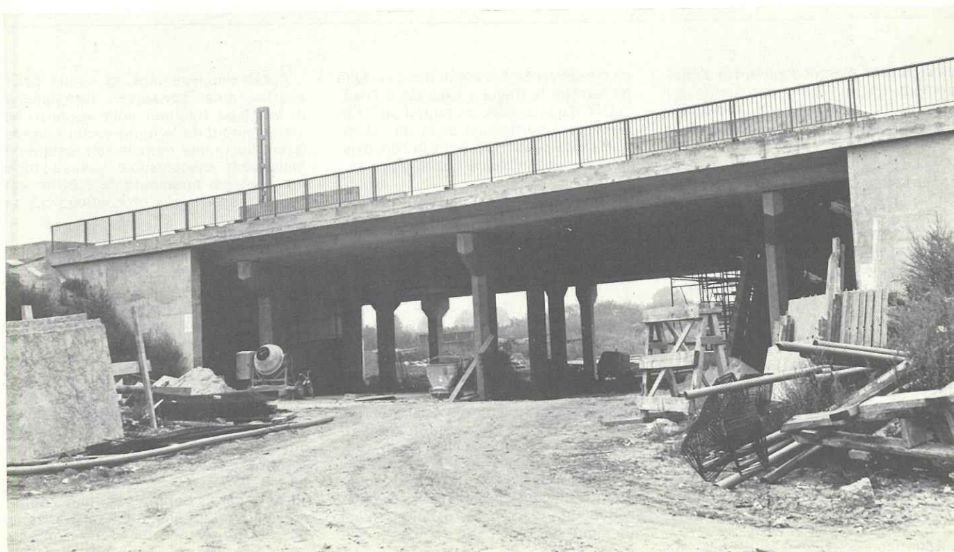
Pont SNCF à Val de Fontenay.
