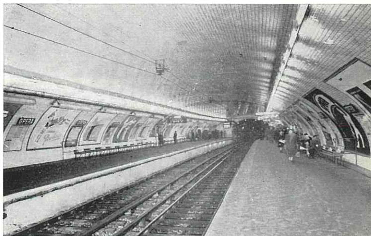
Éclairage standardisé d'une station.
