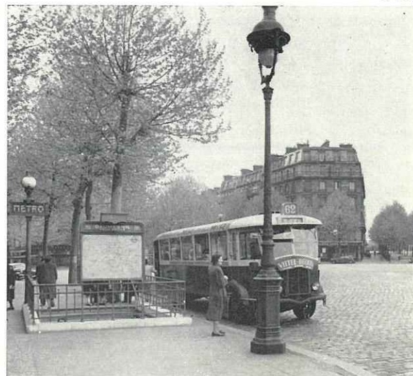
Débouché classique, entourage en fer forgé monté sur socle en pierre de taille de Comblanchien, avec plan et candélabre.
