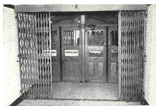
Fermeture de débouché par grilles extensibles. Portes en chêne avec panneaux inférieurs en tôle, persienne et partie haute vitrée.
