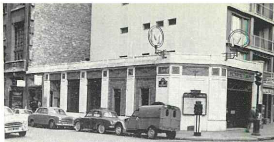
Station « Volontaires » : accès en superstructure.
