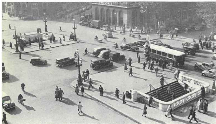
Station « Opéra » : débouchés avec entourages en pierre de taille.
