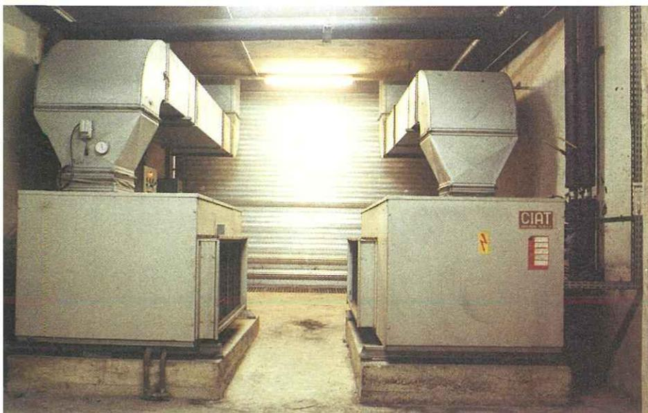
4. Vue des pompes à chaleur dans le conduit de ventilation du métro.
