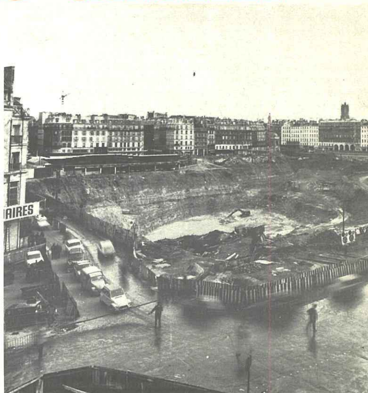
Cliche Travaux Neufs RATP.
