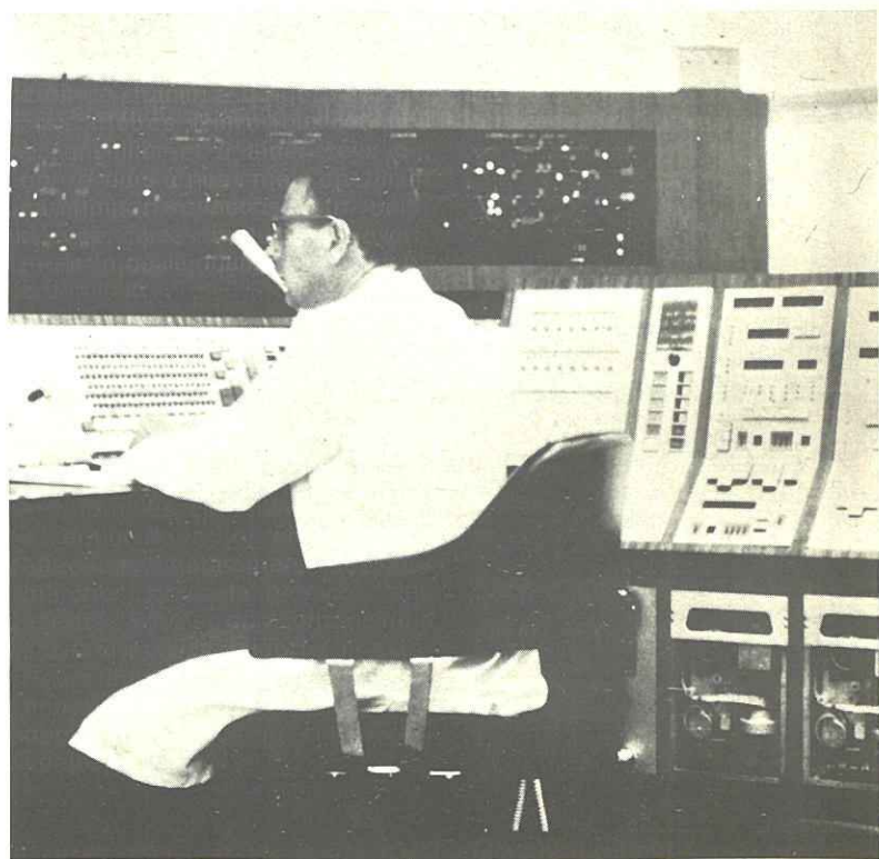
Machines-programmes pour la régulation automatique du dégarage, de l'horaire et de l'intervalle des trains.
