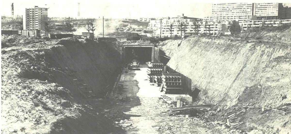
Construction du tunnel à ciel ouvert dans la ZUP de Fontenay.
