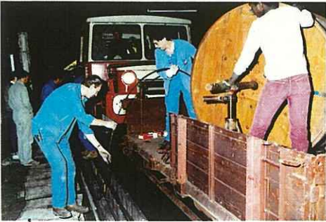
Mise en place, le long des voies du RER, de la liaison expérimentale à fibres optiques reliant Noisy au centre nodal de Bercy.
