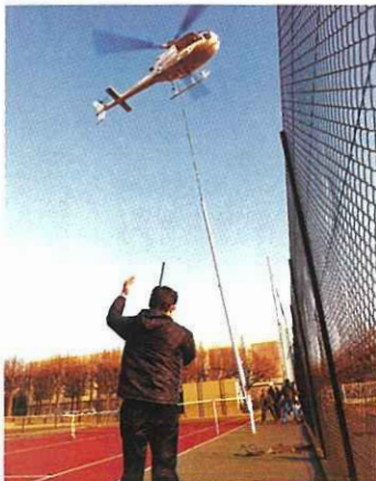
Spectaculaire installation par hélicoptère des pylônes de l'éclairage sur les trois terrains de tennis en quick du stade de la Croix-de-Berry le 14 décembre 1984.
