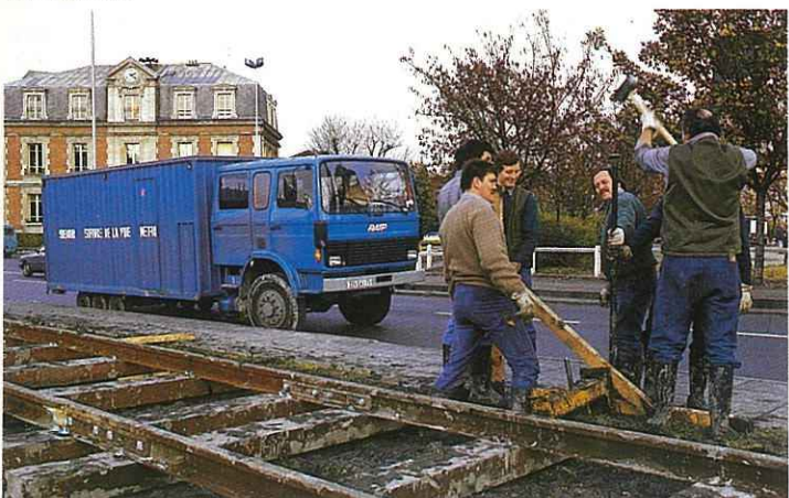
Le nouveau camion de secours sert beaucoup aux équipes de jour ; ici celles de République en train de monter la voie du tramway pour l'expo de Bobigny en novembre dernier.
