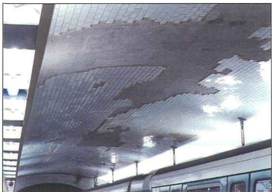
Le remplacement des carrelages détériorés.
