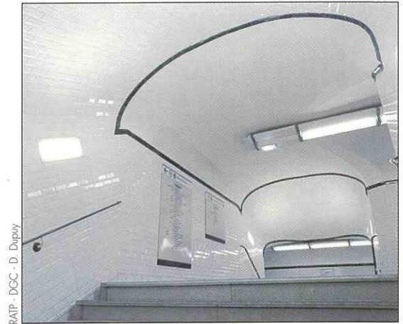
L'éclairage et la céramique rénovés à la station Saint-Ambroise.
