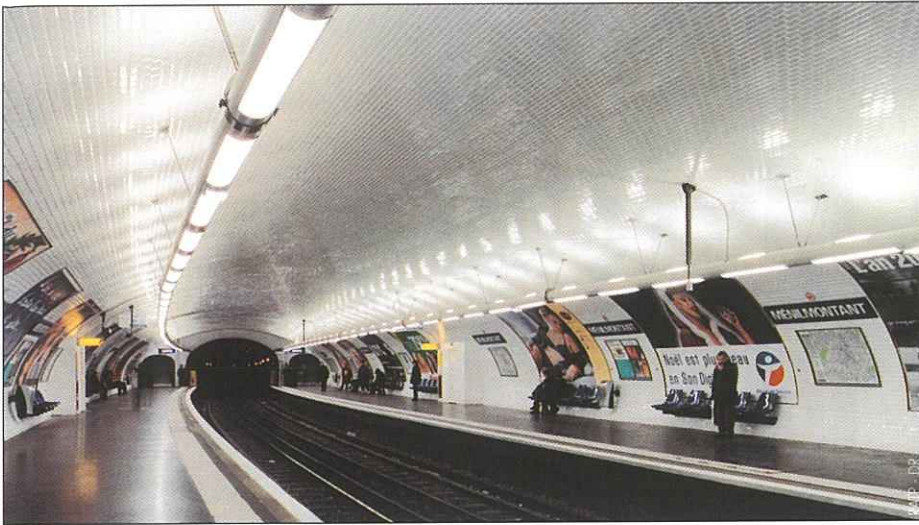
Les quais rénovés de la station Mémorial.
