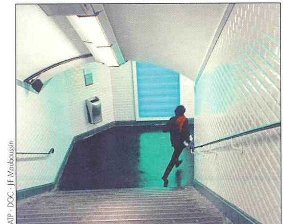
Couloir de correspondance à la station Europe : nouvel éclairage.
