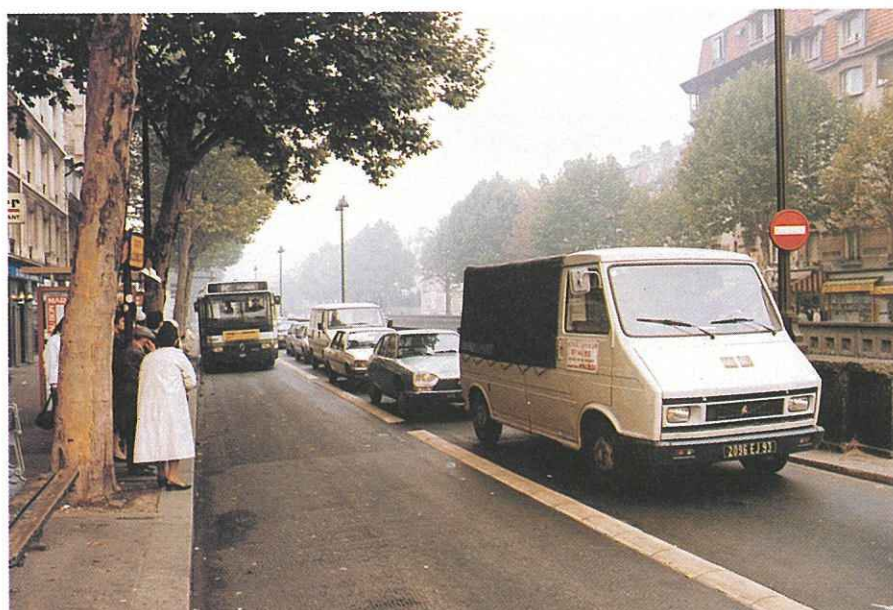
Couloir protégé par des bordurettes (Paris - boulevards extérieurs).
