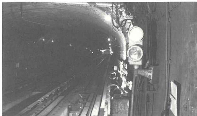
Fig. 40. — Signal d'espacement à deux feux.
