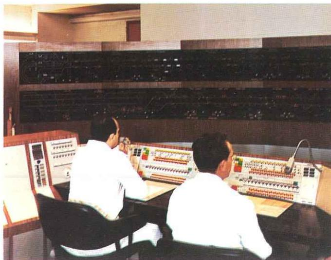
Fig. 44. — P. C. C. : Vue partielle du pupitre de commande et des tableaux de contrôle optique des lignes n<sup>os</sup> 3 et 4.
