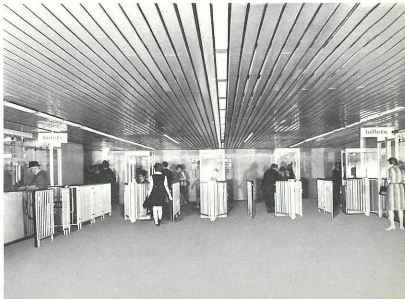
Fig. 17. — Installation de vente et contrôle des billets et des cartes.
