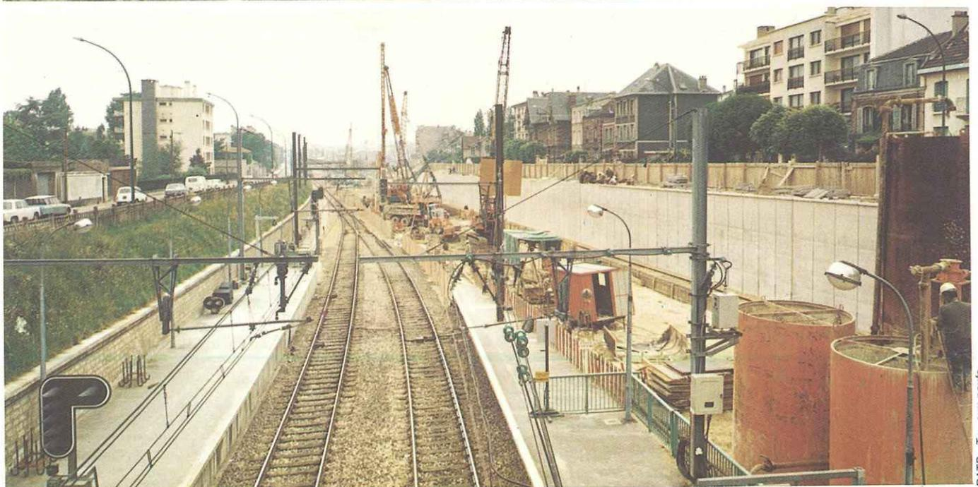
— des ouvrages annexes, d'épuisement des eaux et d'aération ainsi qu'une galerie technique reliant l'ancienne et la nouvelle ligne. Par ailleurs, il faut noter la construction d'un mur de soutènement de 7 m de hauteur sur 231 m de longueur, réalisé à l'abri d'un écran de terre épinglée par des réseaux de pieux « aiguilles ».
