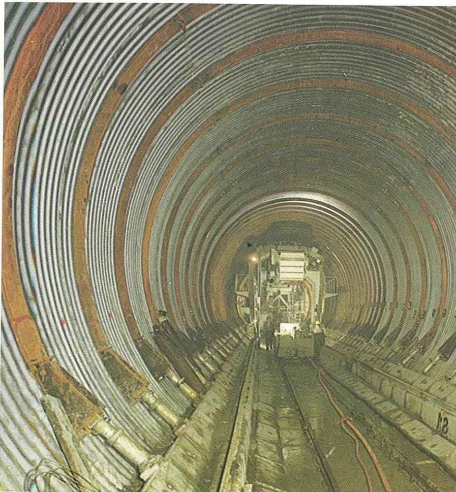
Protection du tunnel par cintres métalliques et tôles ondulées
