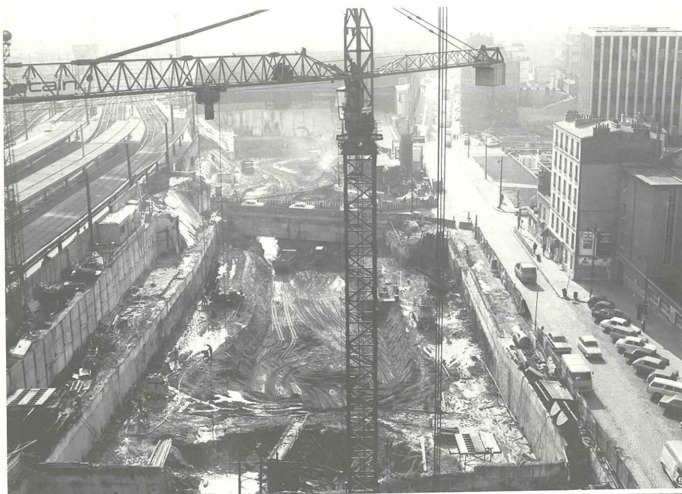
RATP - Travaux neufs
