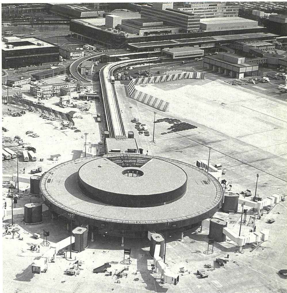
Une navette automatique relie depuis le 23 avril 1983 le bâtiment principal de l'aérogare de Gatwick, près de Londres, à l'un des satellites d'embarquement (au premier plan sur la photo du haut). Le trajet de 335 mètres s'effectue en un peu plus d'une minute. Chaque véhicule peut transporter une centaine de personnes (en bas).
