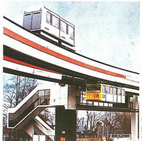
Dessus, dessous : rencontre de deux cabines du système allemand C-Bahn.
