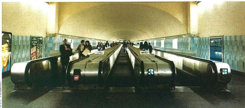
Le trottoir roulant à vitesse constante de Montparnasse l'un des premiers mis en service par la RATP.
