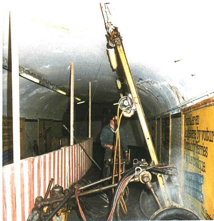
Forages pour sondage du terrain et reprise des fondations d'une portion de couloir à « Bastille ».
