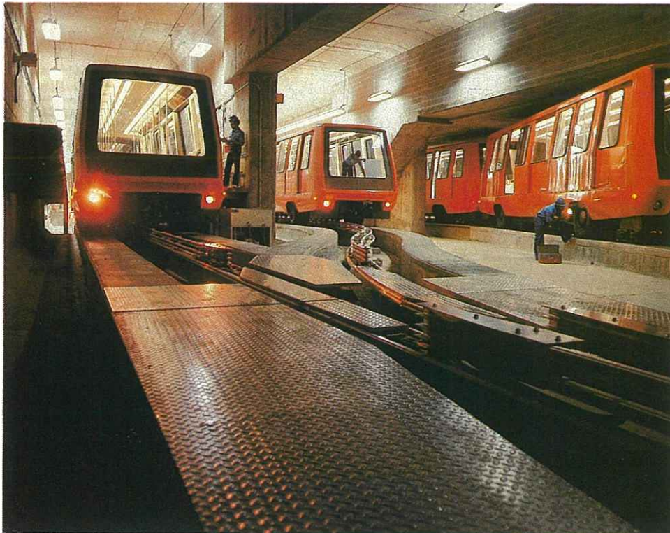
L'atelier d'entretien (en haut) et le poste de commande central (en bas) du système de desserte automatique de l'aéroport d'Atlanta.
