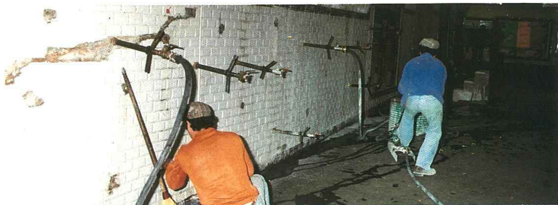
« Concorde », couloir de correspondance entre les lignes 1 et 12 : travaux d'injection en vue de consolider l'ouvrage.
