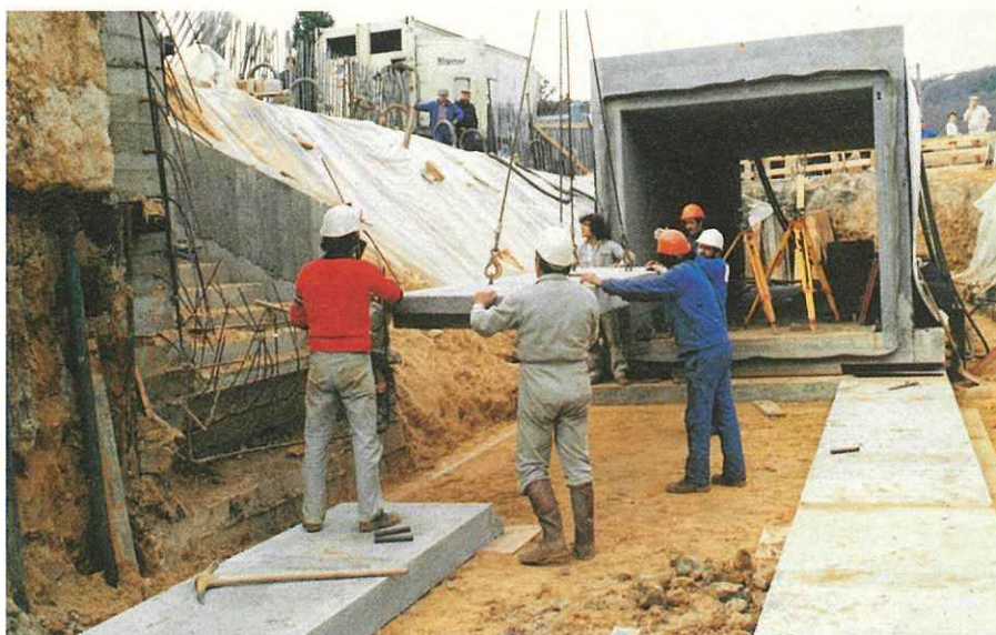
Fig. 8 — La mise en place des longrines de ripage du passage piétons du PN 28 (samedi 16 avril - 15 h).
