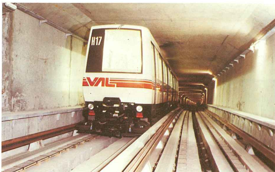
Une rame en tunnel.
