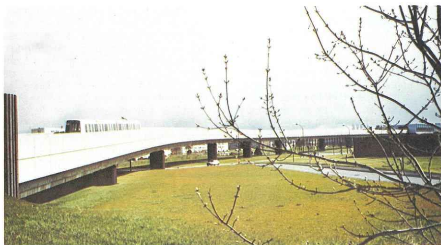
Le viaduc dans le centre universitaire de Villeneuve d'Ascq.
