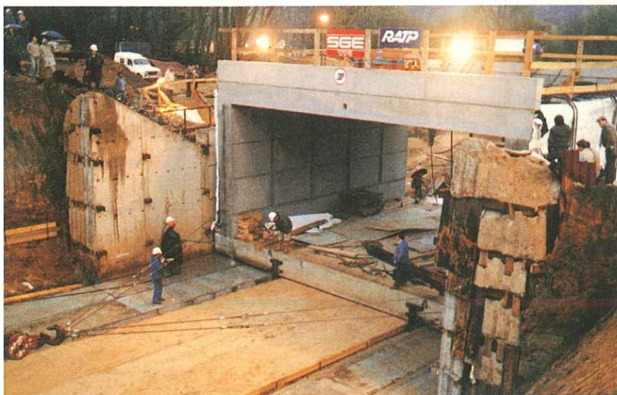
Fig. 9 — Le ripage du passage routier du PN 28 (dimanche 17 avril - 7 h).
