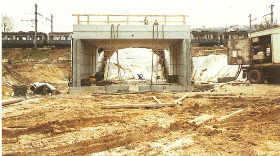
Fig. 6 — Le cadre préfabriqué du passage routier du PN 28.
