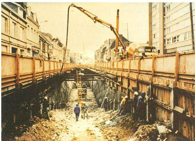
Exécution de la tranchée couverte.
