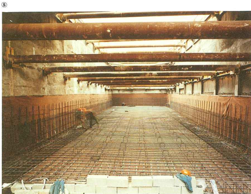
Métro - Ligne 7 : Prolongement au nord, à La Courneuve. ⑤ Ferrailage du radier du souterrain de garage à l'extrémité du prolongement.
