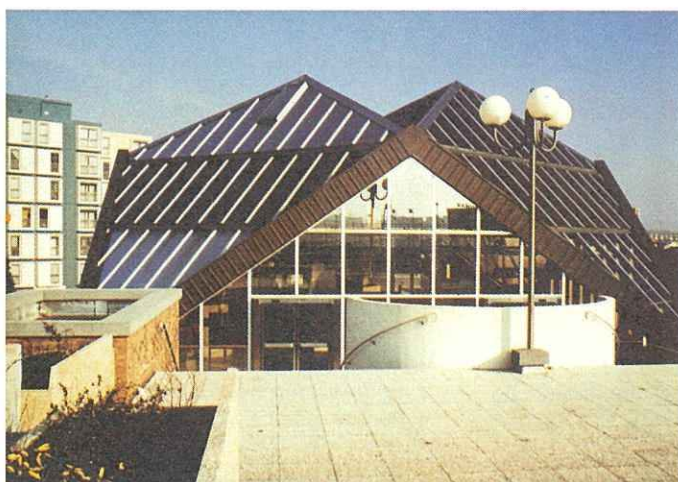
Vue extérieure de la station « Triolo ».
