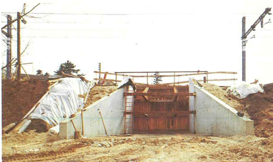
Fig. 4 — Les travaux préparatoires du PN 24 côté Nord.
