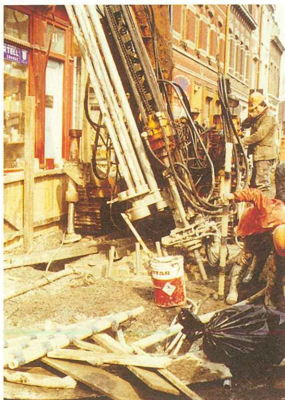
Foreuse pour injections dans le calcaire fissuré.
