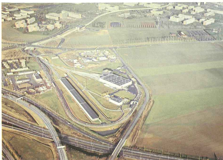
Vue aérienne du garage-atelier de Villeneuve d'Ascq.
