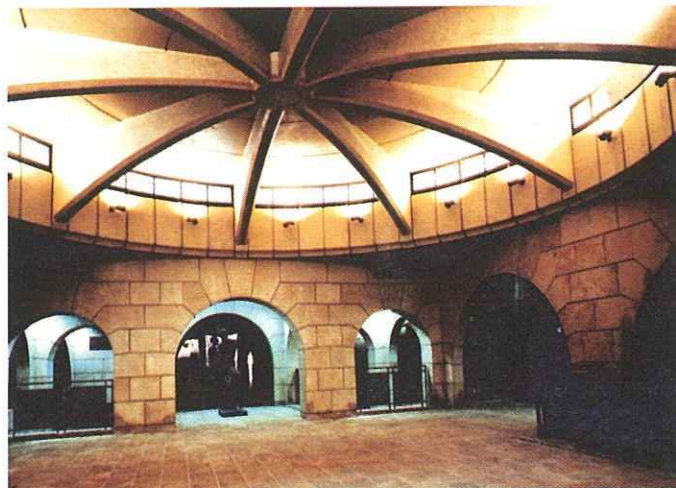
Station « République » : niveau intermédiaire.
