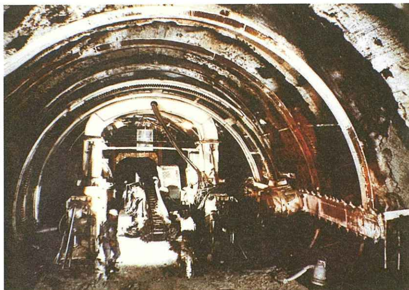
Machine « haveuse » à prédécoupage de la voûte.
