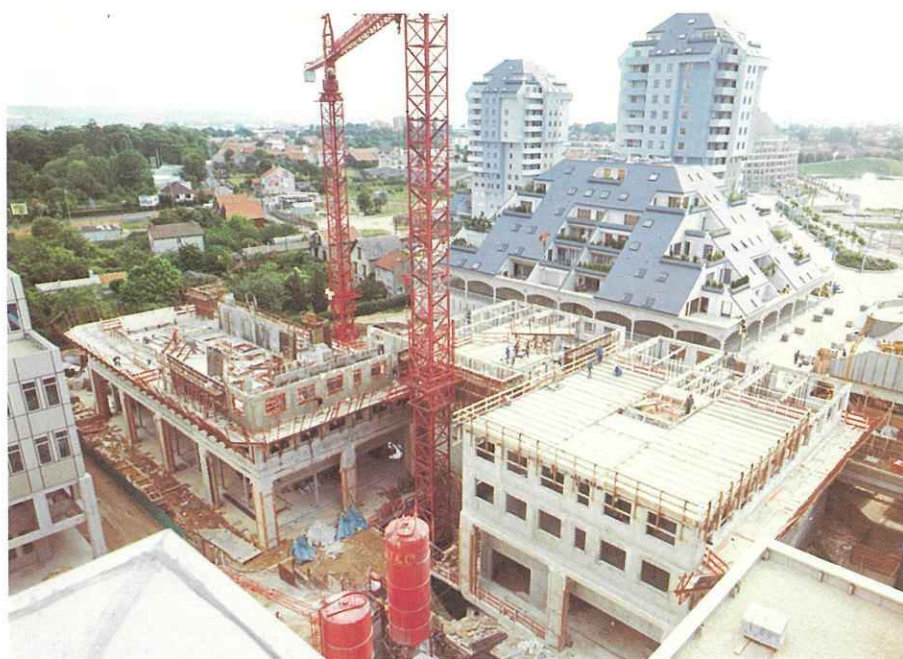
Le chantier de construction en juin 1981.
