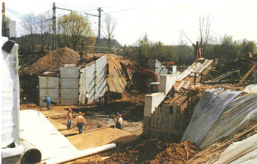
Fig. 7 — Le terrassement du passage routier du PN 28 (samedi 16 avril - 14 h)
