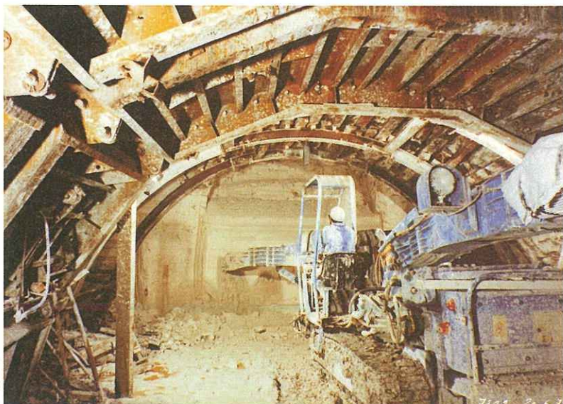
Machine « blaireau » à attaque ponctuelle.
