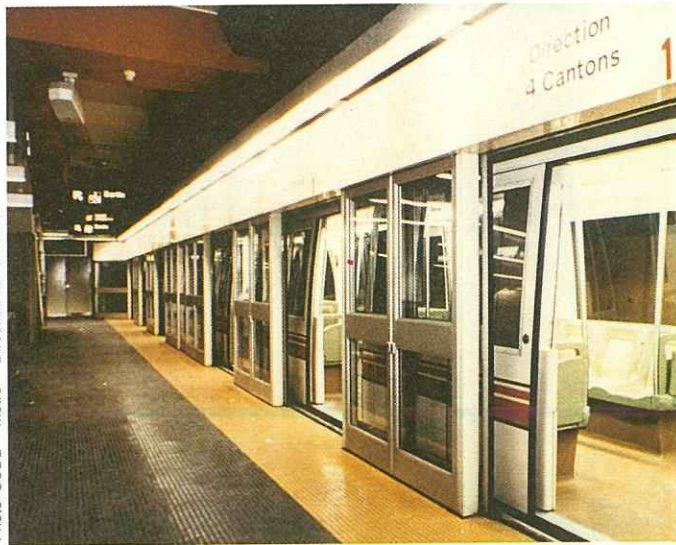
Quai de station avec portes palières.
