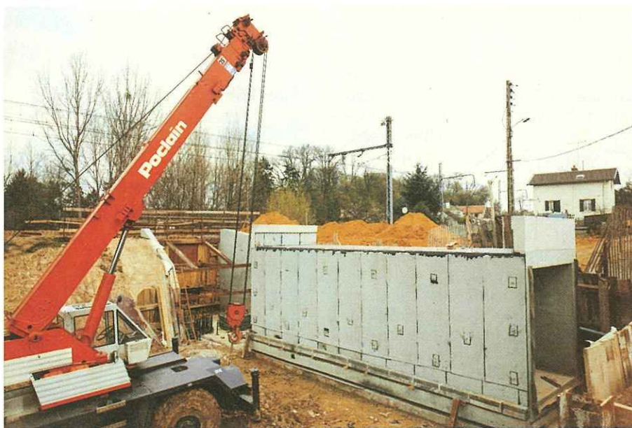
Fig. 5 — Le cadre préfabriqué du PN 24.
