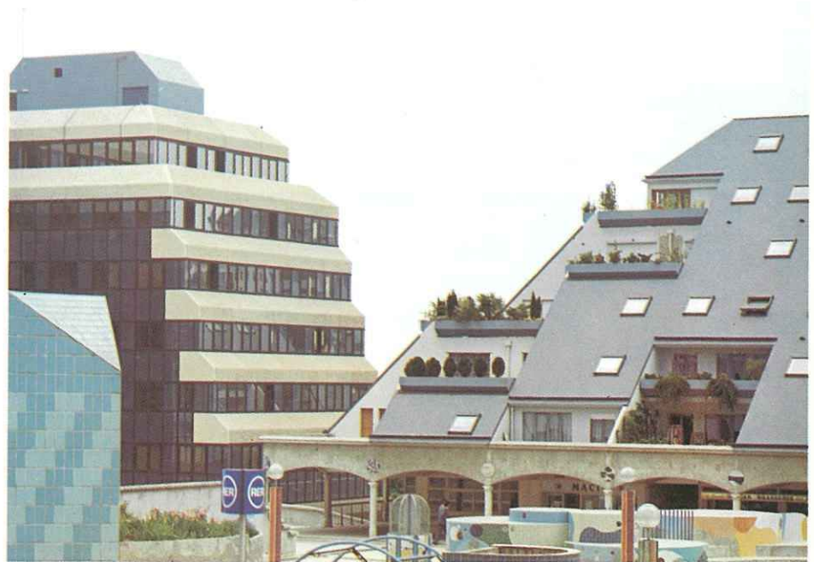
La façade Est de l'immeuble.
