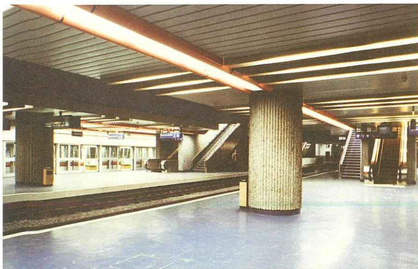
Station « Gares » : niveau des quais.
