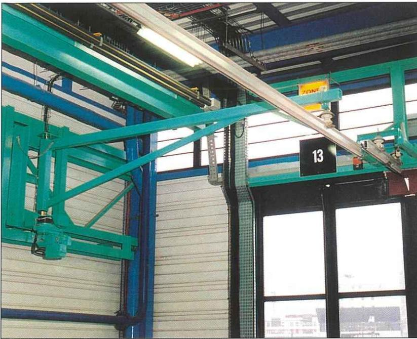
L'interface LAC/caténaire escamotable assurant la continuité de l'alimentation du pantographe.
