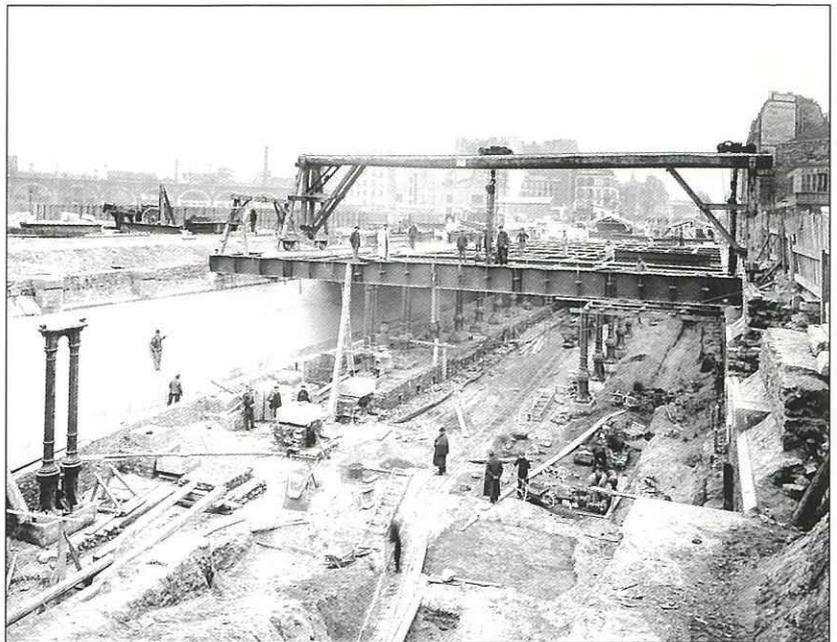
Mise en place du tablier métallique de la station Gare de Lyon (ligne 1) en 1900.
