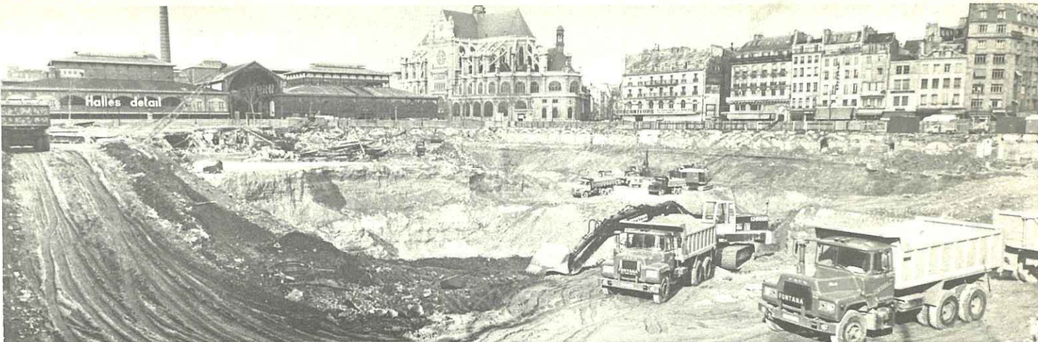
Cliché travaux neufs RATP
