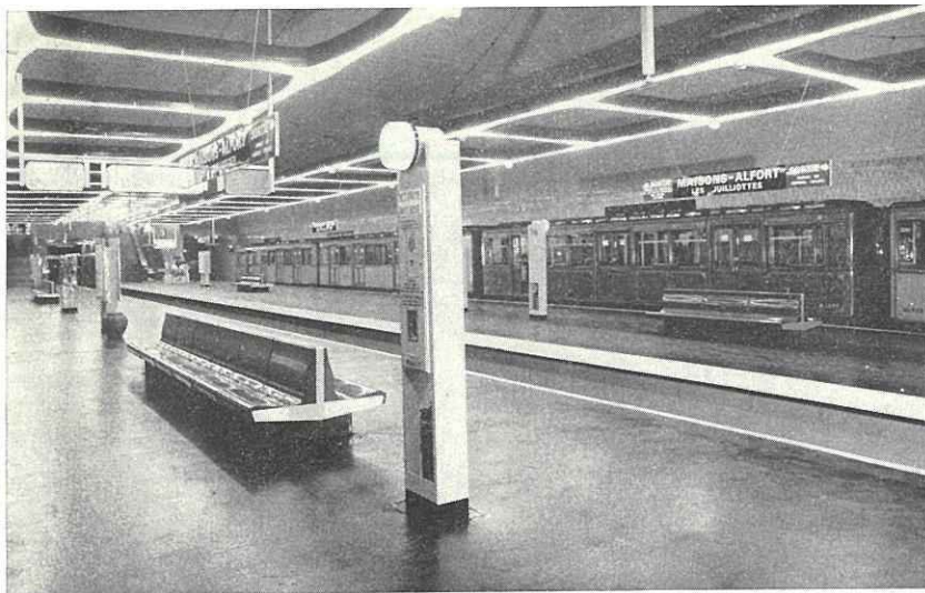
Vue des quais avec armoire de sécurité permettant aux voyageurs de signaler un incident et au bureau de station de s'adresser aux voyageurs
