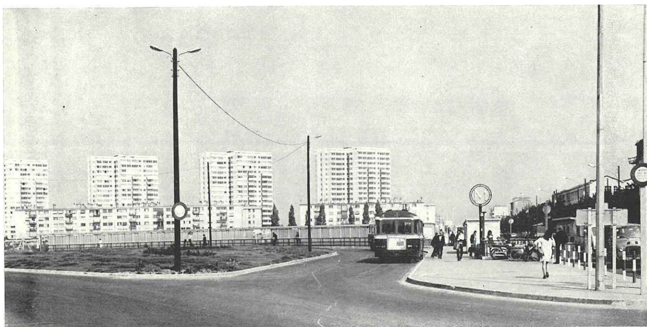
Vue extérieure : terminus routier
