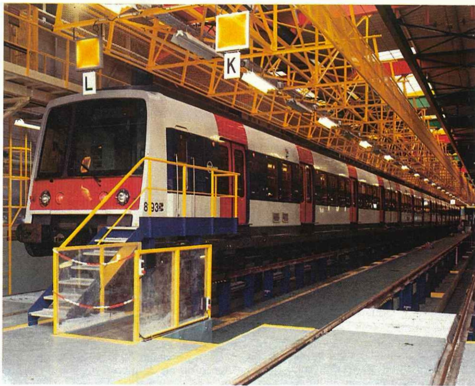
Le nouveau hall d'entretien de Boissy-Saint-Léger : de nouvelles installations pour de meilleures conditions d'exploitation.
