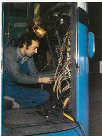
C'est un véritable tour de force de ne pas s'égarer dans cet écheveau de fils et de câbles.
