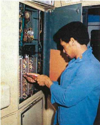
Opération terminée... Reste à contrôler une dernière fois le serrage des multiples connexions.
