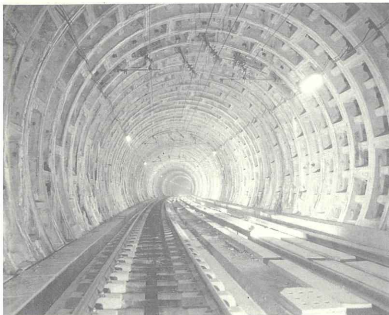
Tunnel de section circulaire (près de LA DÉFENSE)
