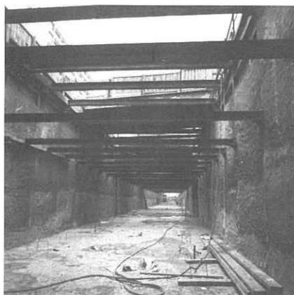
Fig. 23 : Butonnage de la fouille du tunnel à deux voies.
