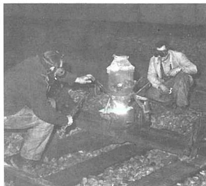
Réalisation d'une soudure aluminothermique de rails.
