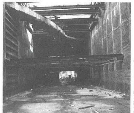
tion d'accès et de locaux techniques très peu enterrés, remaniement complet des réseaux qui, après pose à neuf sous fourreaux, ont été, soit enrobés dans la dalle de couverture, soit placés dans des caniveaux réservés dans celle-ci (2 conduites de gaz, 1 conduite d'eau, 1 câble électrique, 1 câble téléphonique).
