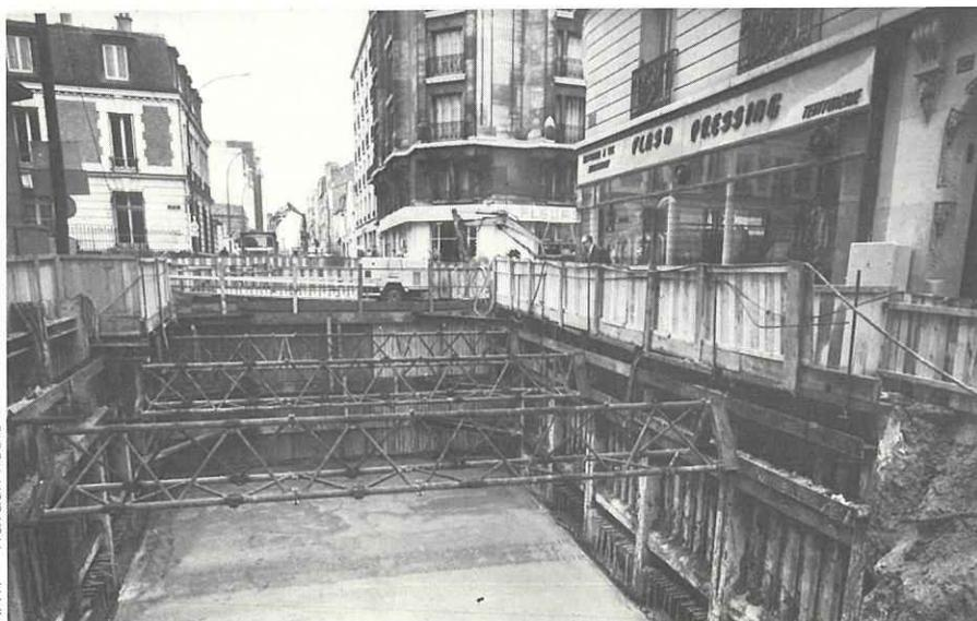
Par ailleurs, la méthode utilisée pour exécuter le tunnel a permis de réduire au maximum la gêne que provoquent inévitablement pour la circulation des travaux réalisés à ciel ouvert: une dalle de couverture, prenant appui sur les parois préfabriquées, a été bétonnée au sol puis, après rétablissement de la chaussée et de la circulation, l'excavation du tunnel a été entreprise en sous-œuvre, à l'abri de cette dalle.
