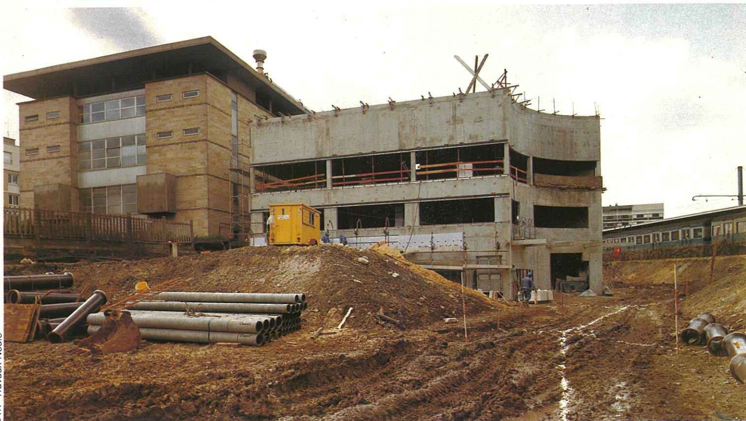
Le futur PCC de Denfert en cours de construction
