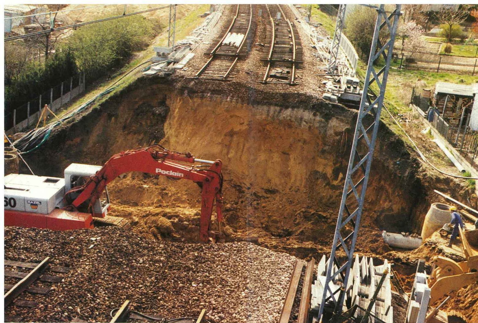
Le résumé photographique de la situation : à gauche, l'ouvrage routier de 750 tonnes de Palaiseau-Villebon ; à droite : la brèche dans le remblai de la ligne B où mettre l'ouvrage. Entre les deux, une trentaine de mètres de terrains instables et gorgés d'eau.
