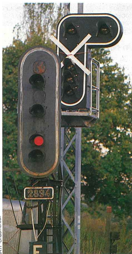
La mise au code SNCF de la ligne B a nécessité le remplacement de 195 cibles lumineuses.
