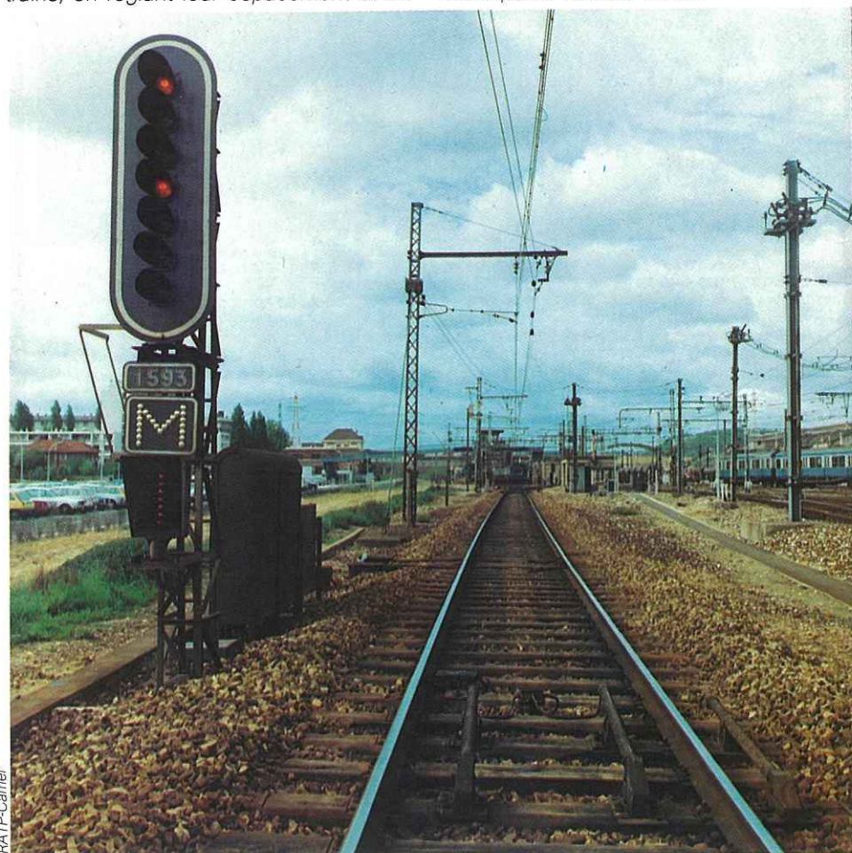
Ce signal de manœuvre sur voie principale, reconnaissable à sa plaque M, gardait l'entrée de la gare de Massy-Palaiseau. Les deux feux jaunes superposés transmettaient l'indication « avertissement », imposant un ralentissement à 50 km/h aux trains de voyageurs. On remarque, parallèlement aux voies, les inducteurs permettant la répétition ponctuelle des signaux sur les trains ; ce mode de répétition était l'une des grandes nouveautés de la signalisation « ligne de Sceaux ».
