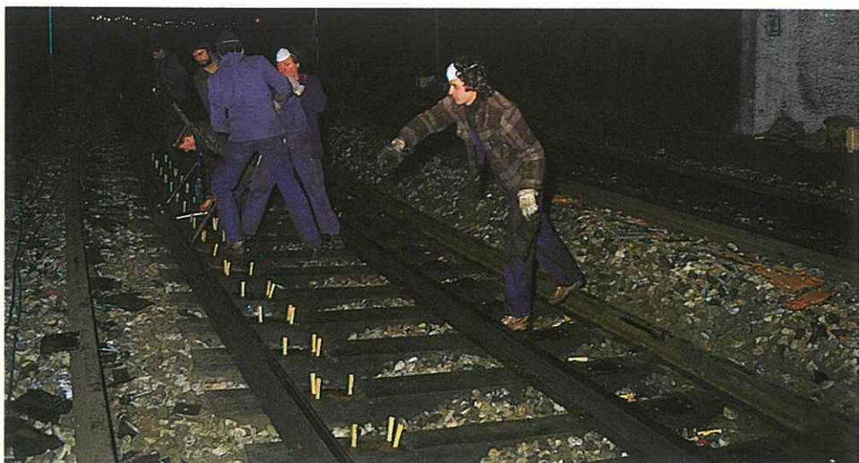
Avant le passage de la machine, on ripe l'ancien rail et l'on bouche avec des chevilles en bois les trous laissés par les anciens tire-fonds dans les traverses.
