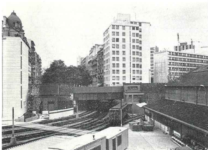
Vue de l'atelier depuis l'immeuble de la rue Croulebarbe vers l'avenue de la Sœur-Rosalie; amorce du raccordement des voies avec le réseau souterrain.
