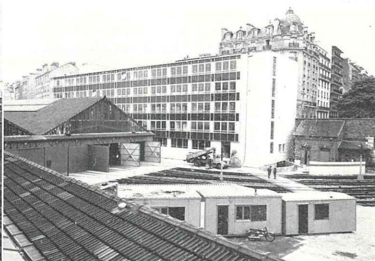
Vue de l'atelier depuis l'immeuble de la rue Croulebarbe : — à gauche, les halls d'entretien; — au centre, le nouveau bâtiment; — au premier plan, baraquements provisoires pour les travaux en cours.
