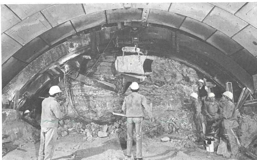
Illustration n° 7 : Souterrain de 12,00 m d'ouverture aux abords de Gare du Nord - pose d'un voussoir
