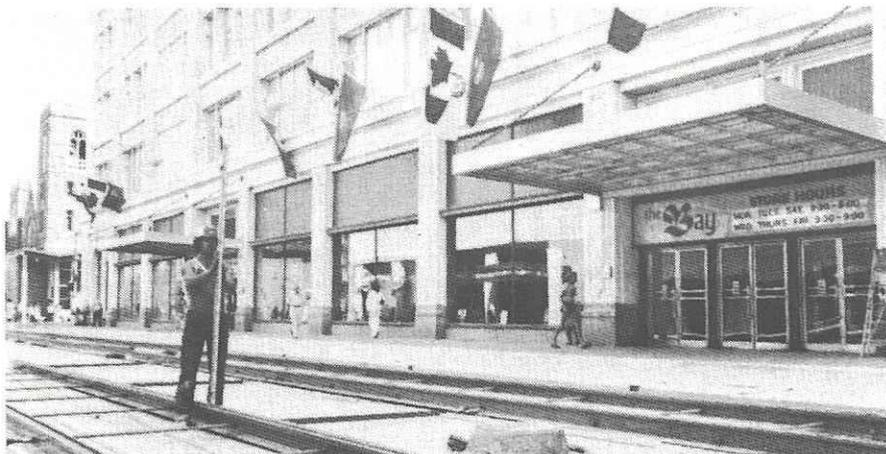
Méto léger de Calgary : sur la 7ème Avenue, encastrement de la voie dans la chaussée pour permettre la circulation des autobus
