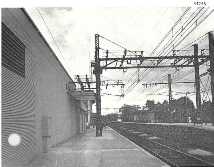
Le bâtiment du poste, côté quai, et les départs en ligne.
