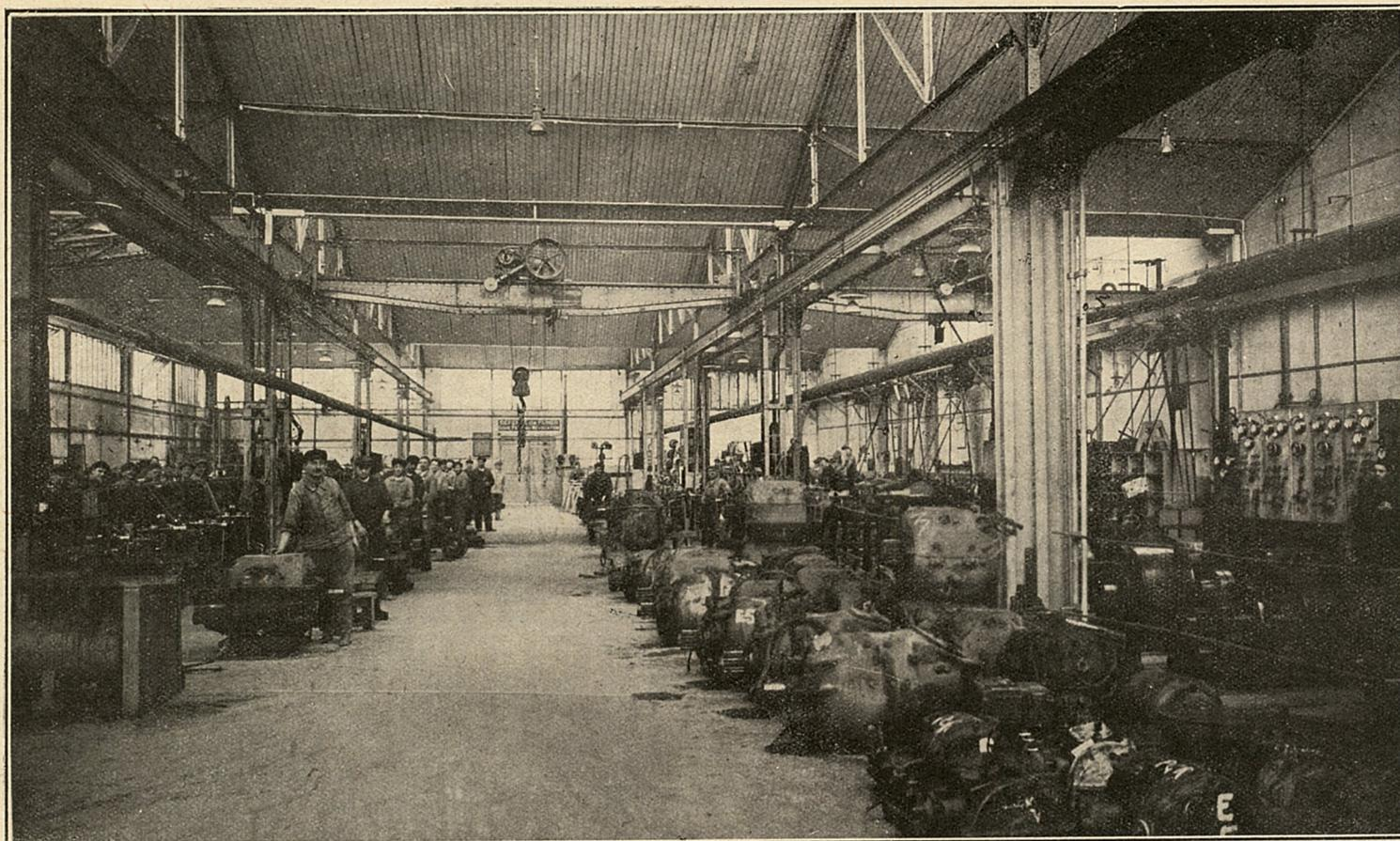
L'Atelier de réparation des moteurs électriques et de l'appareillage. — On voit, à droite, au premier plan, la plateforme d'électricité. Au milieu, les trois ponts roulants desservant cet atelier.
