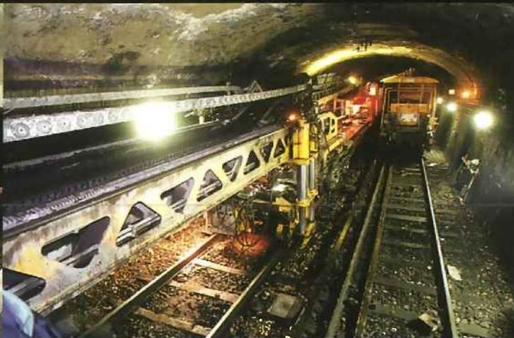
2. Installation et déploiement de la dégarnisseuse, qui assure l'extraction mécanique du ballast.
