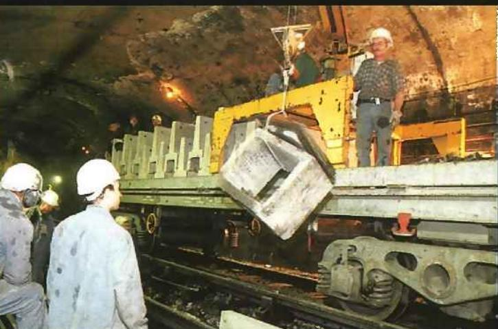
6. Dépose des vieux drains, qui permettent d'évacuer l'eau, et repose des murettes d'une hauteur de 85 centimètres. Les murettes sont installées seulement lorsque le radier (partie basse du souterrain supportant le ballast) est profond.
