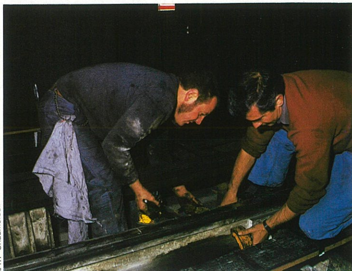
Les équipes de la voie éclissent les appareils de voie de l'ancien terminus de Kremlin-Bicêtre.
