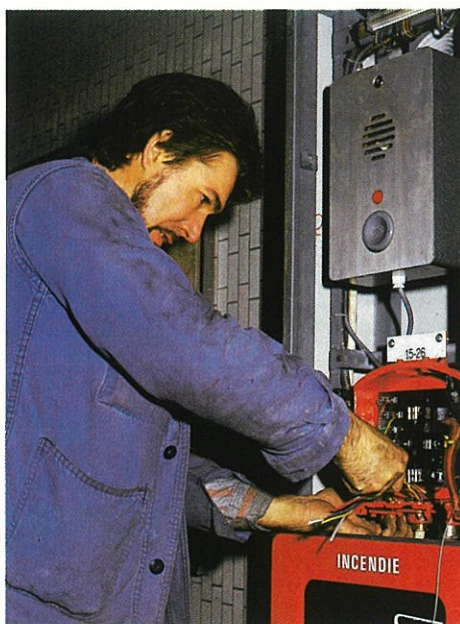
Mise en place des avertisseurs d'alarme.
