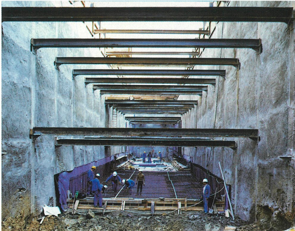
Construction du radier du tunnel près de la station Paul Vaillant-Couturier.
