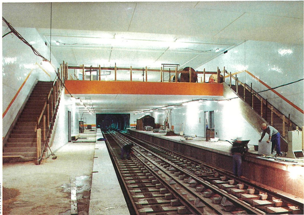
Villejuif-Paul-Vaillant-Couturier : Mai 1983 (en haut) le gros œuvre est terminé, octobre 1984 (en bas) on équipe la station.
