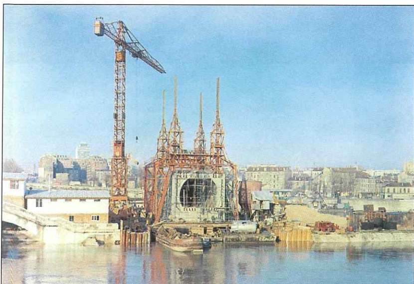
Préfabrication fin 1965 d'un caisson de la traversée sous-fluviale de la Seine par la nouvelle ligne RER au pont de Neuilly.
