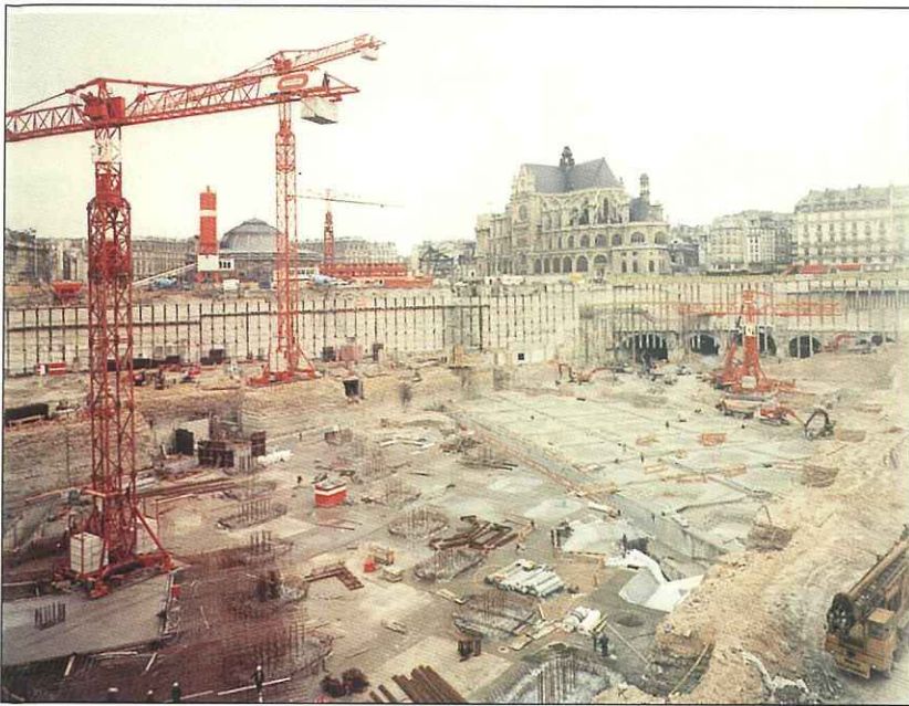
L'immense chantier de Châtelet-Les Halles avec à droite l'amorce des tunnels du RER.
