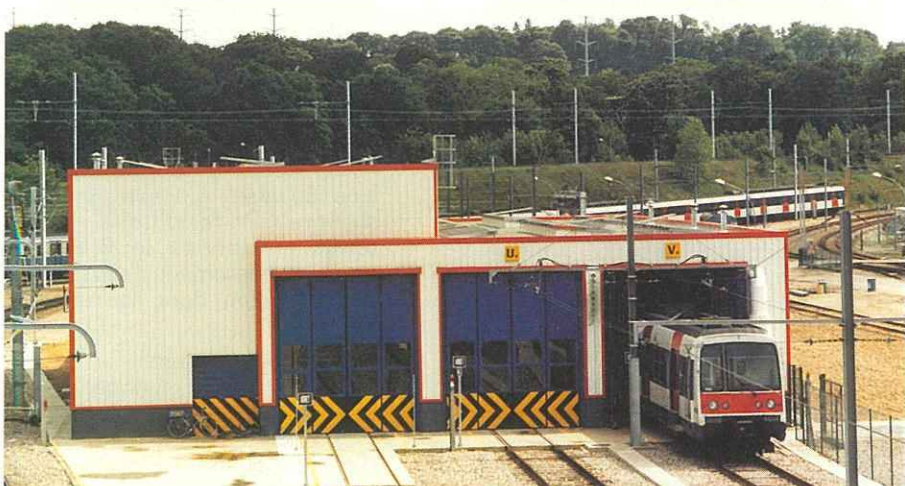
Le vérin en fosse : hall et équipements.
