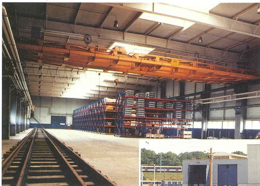
Les nouvelles installations du parc PAE.
