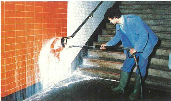
Ces carrelages sont nettoyés à l'eau chaude haute pression.
