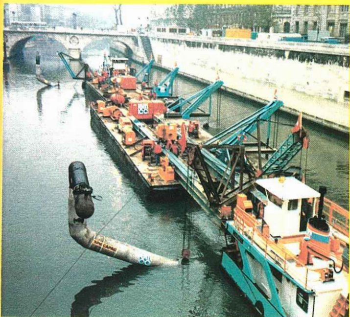
RATP - Travaux Neufs
