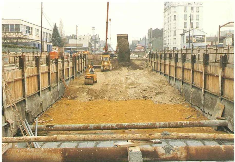
16. Remblaiement à l'avancement sur le tunnel terminé.
