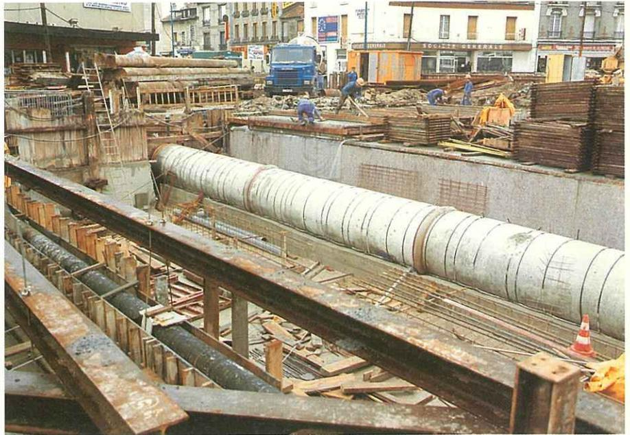
17. Mise en place de la nouvelle conduite d'eau  $\varnothing$  1 250 mm sur la couverture de la station à la limite sud de la mezzanine.
