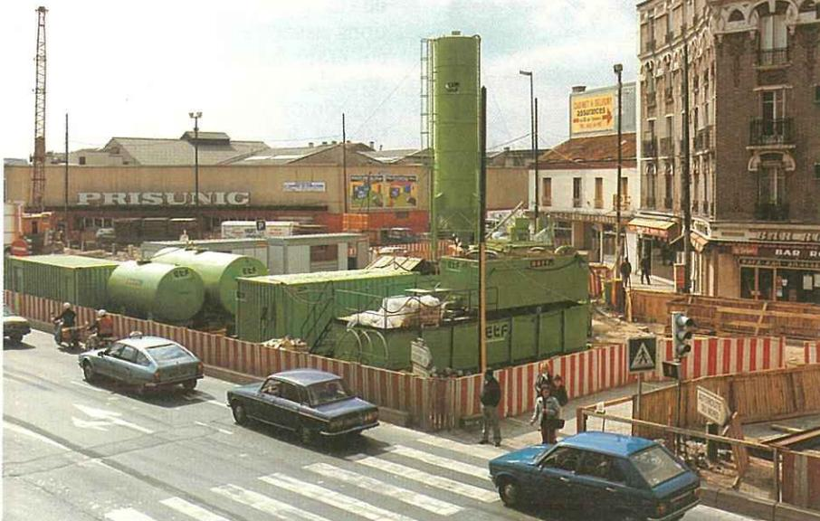
12. Centrale d'injections installée sur la place du 8 mai 1945 pour remplissage des vides de dissolution du gypse et traitement du terrain de fondation des immeubles riverains.
