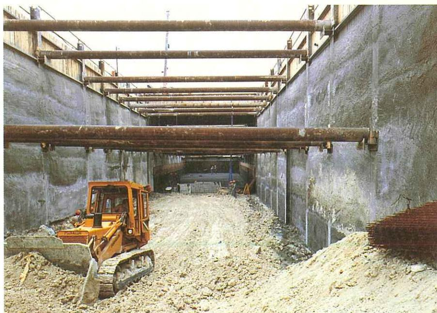
10. Blindage berlinois en béton projeté armé par un treillis soudé.
