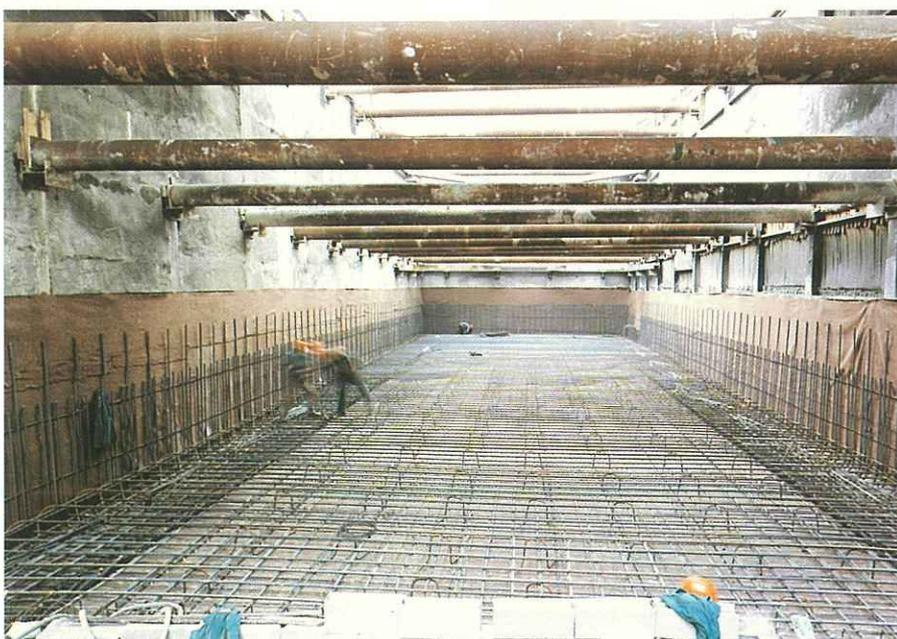
14. Ferrailage du radier de l'extrémité du tunnel de garage des trains (remarque le butonnage par des tubes et les feuilles d'étanchéité en attente).
