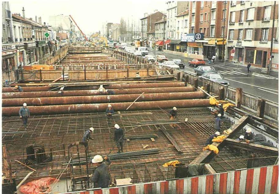
15. Coffrage et ferrailage de la dalle de couverture de la station.
