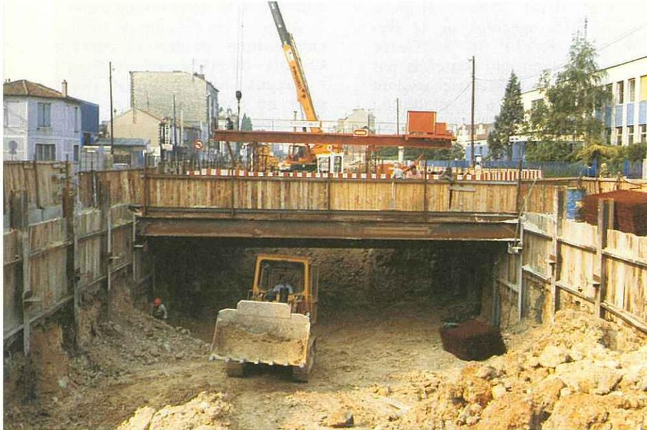
18. Passage du terrassement sous un pont d'accès à une propriété riveraine (profilés métalliques + platelages en béton armé revêtus d'enrobés routiers).
