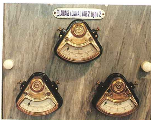
Le tableau d'éclairage : installé sur plaques de marbre pour améliorer l'isolation.
