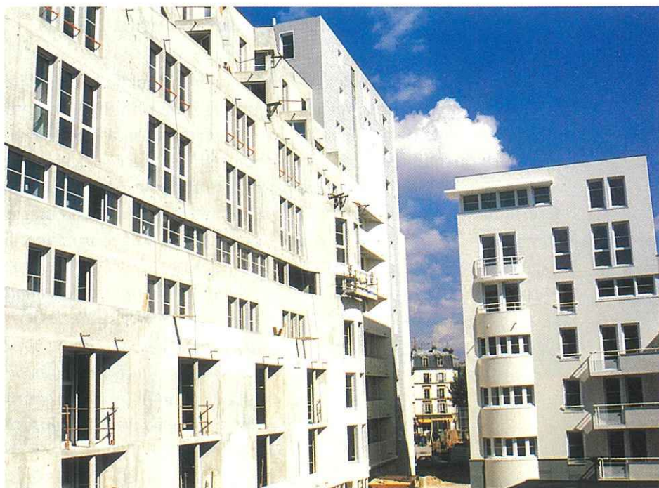
Clichy : un programme dense qui préserve le caractère intime du quartier.
