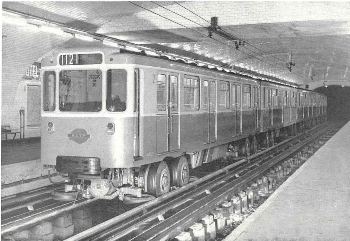
Fig. 1. — Matériel roulant sur pneumatiques de la ligne n° 11
