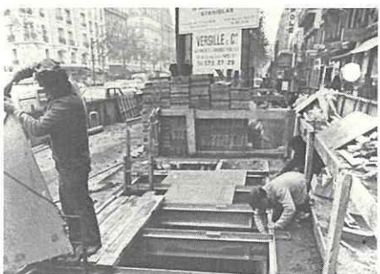
Fig. i . . . en cours de réalisation
