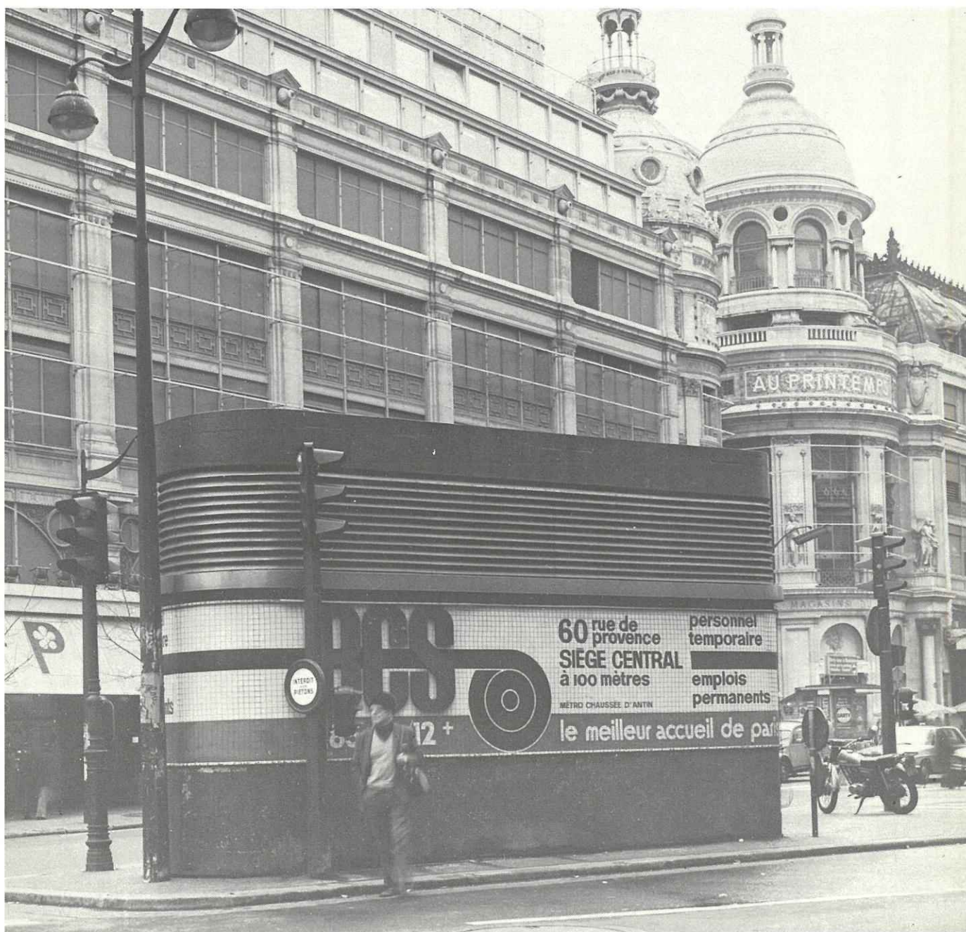
Gaine de ventilation d'Auber
